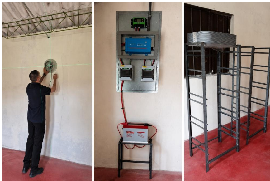
Figura 25. Instalación del sistema fotovoltaico para la generación de energía eléctrica y bastidores para secado. Municipio Herveo Tolima
