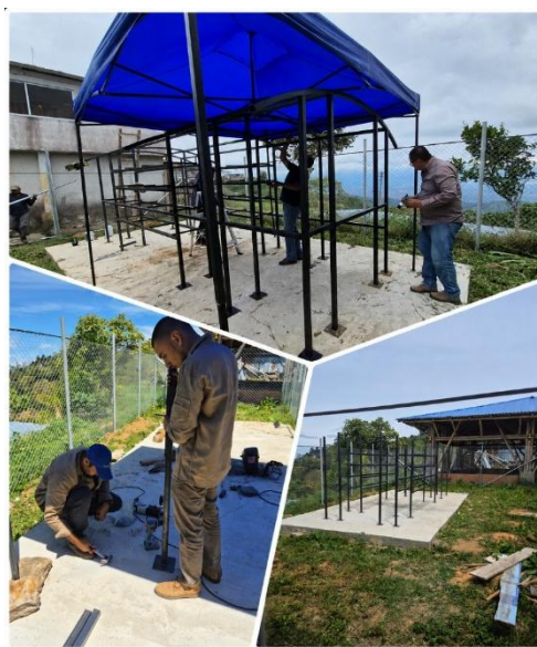
Figura 23. Construcción de estructura metálica para el secador solar corregimiento de San Rafael municipio de Santa Isabel, Tolima.
