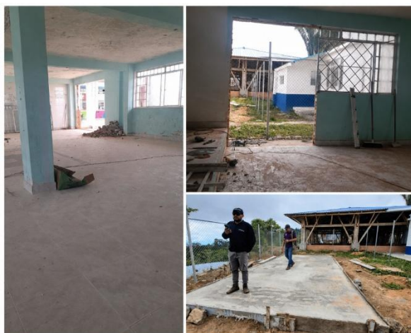
Figura 22. Adecuaciones de infraestructura planta piloto para la agroindustria del plátano ubicada en el corregimiento de San Rafael municipio de Santa Isabel, Tolima.
